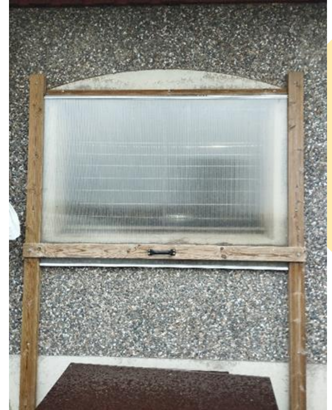
Ikkunat muutoksen jälkeen
