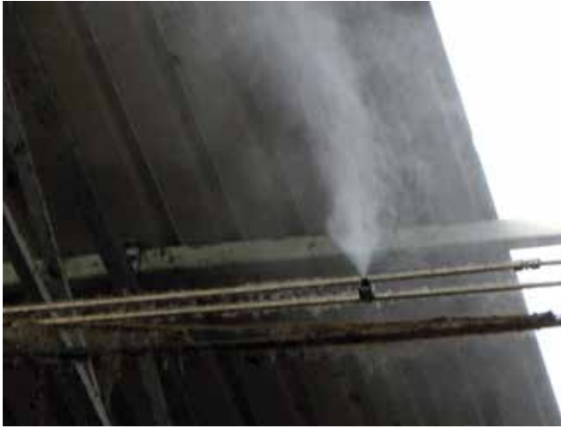
Tässä minkkihallissa sumutusautomaattiikka hoitaa jäädytyksen lämpötilan noustessa liian korkealle.
