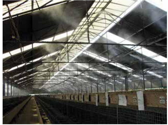
Tässä minkkihallissa sumutusautomaattiikka hoitaa jäädytyksen lämpötilan noustessa liian korkealle.
