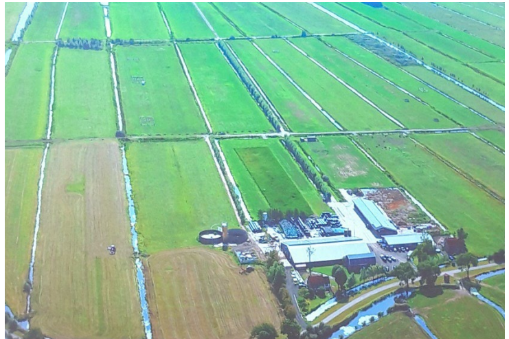
Tutkimuskeskuksen ilmakuvaista hahmottuu tilusrakenne. Tiheä kanavarakenne mahdollistaa pohjaveden pinnannoston -20 cm melko yksinkertaisilla toimenpiteillä.
