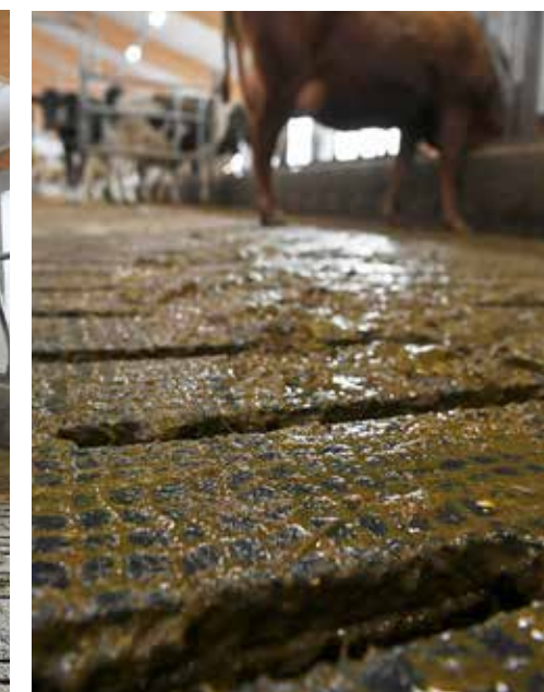
Ruokintakäytävän lietekuilu on kolme metriä leveä ja 64 metriä pitkä. Kuilun syvyys on 1,2 metriä. Kuilun pohjalla on rinnakkain neljä liete- ja maalämmön keruuputkea. Puhdistusroboti putsaa käytävää.
