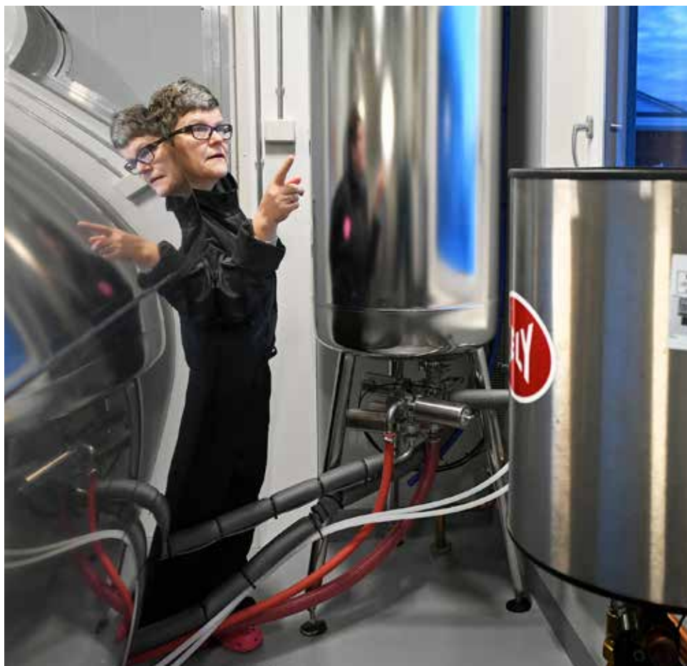
Kannuksen opetusnavetassa lämpöä otetaan talteen myös maidon esijäähdytyksessä. Projekti-päällikkö Maarit Kärki esittelee laitteistoa, etenkin cooleria.
