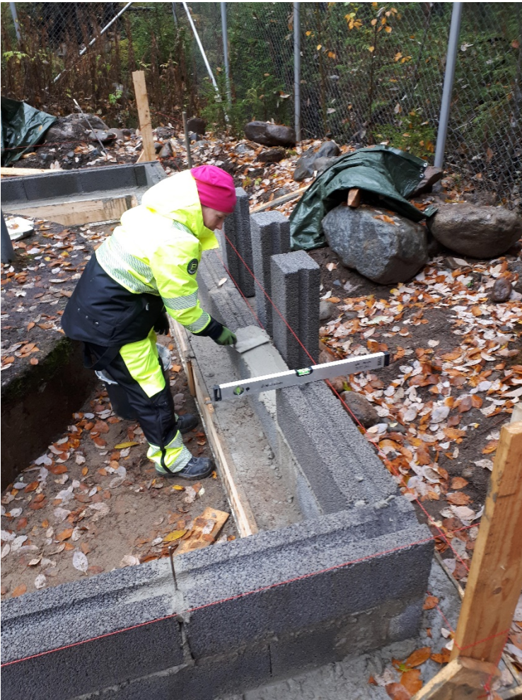
Kuva 6. Eija Taivassalo muuraamassa ulkorakennuksen sokkeliä kevytsoraharkoista
