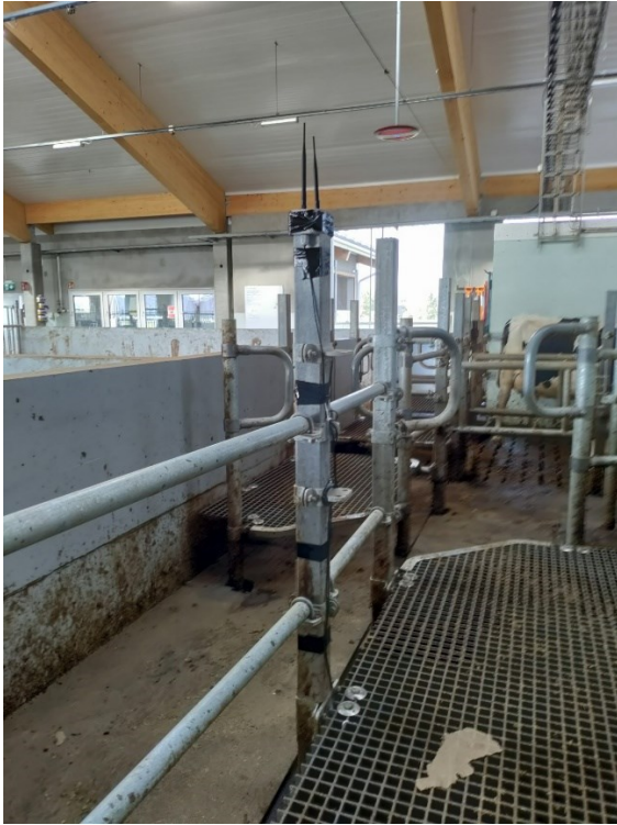
Kuva 8. Lämpötilamittareiden paikka navetassa.
