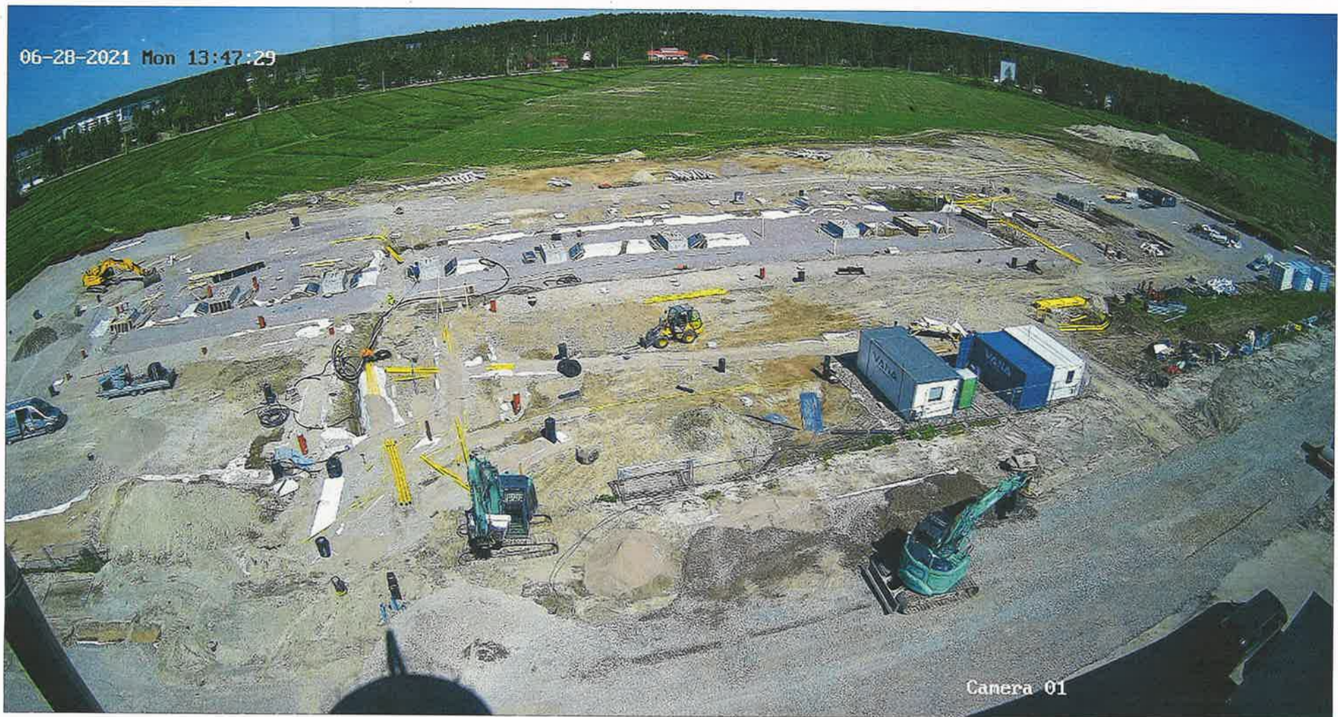
Työmaalta. Uusi moderni opetusnavetta rakentuu vanhaa navettaa vastapäätä Ollikkalankadulle. MAARIT KÄRKI
