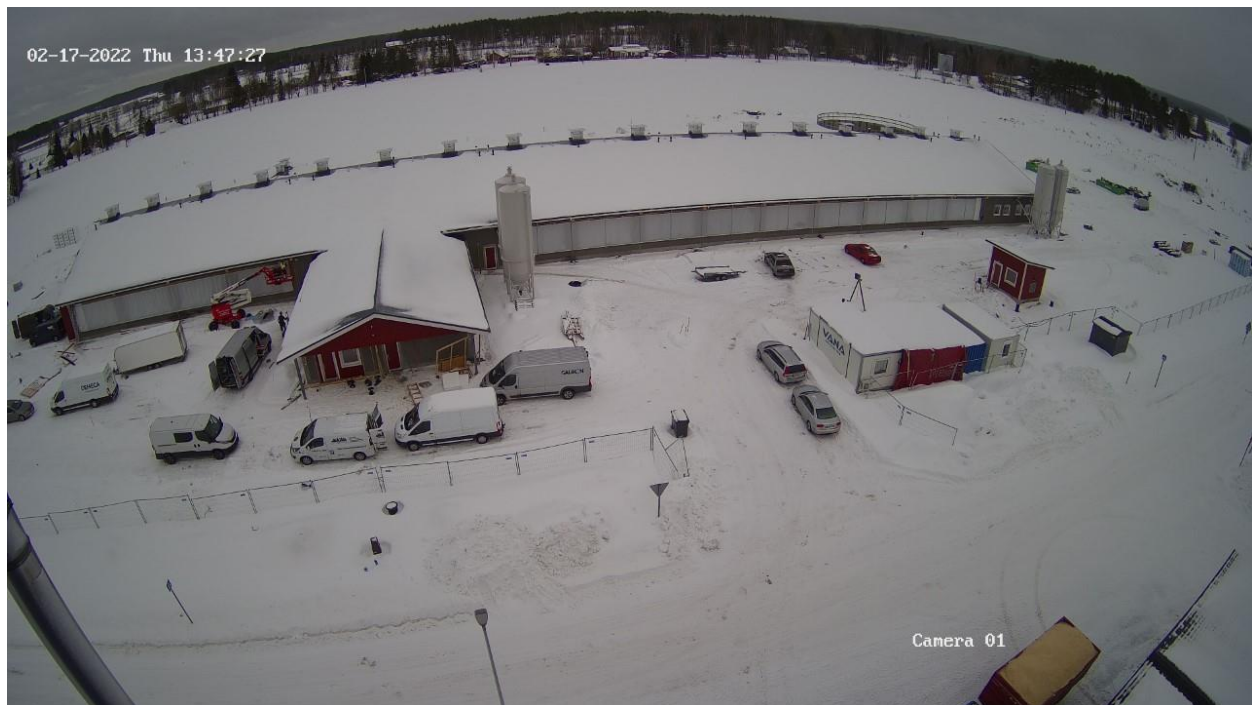
Kuva 2 Navetan rakennustyöt ulkoa helmikuussa 2022
