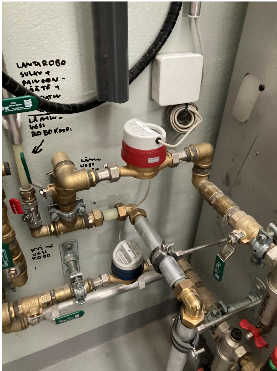
Kuva 5 Lypsyrobotin vedenkulutusmittarit
