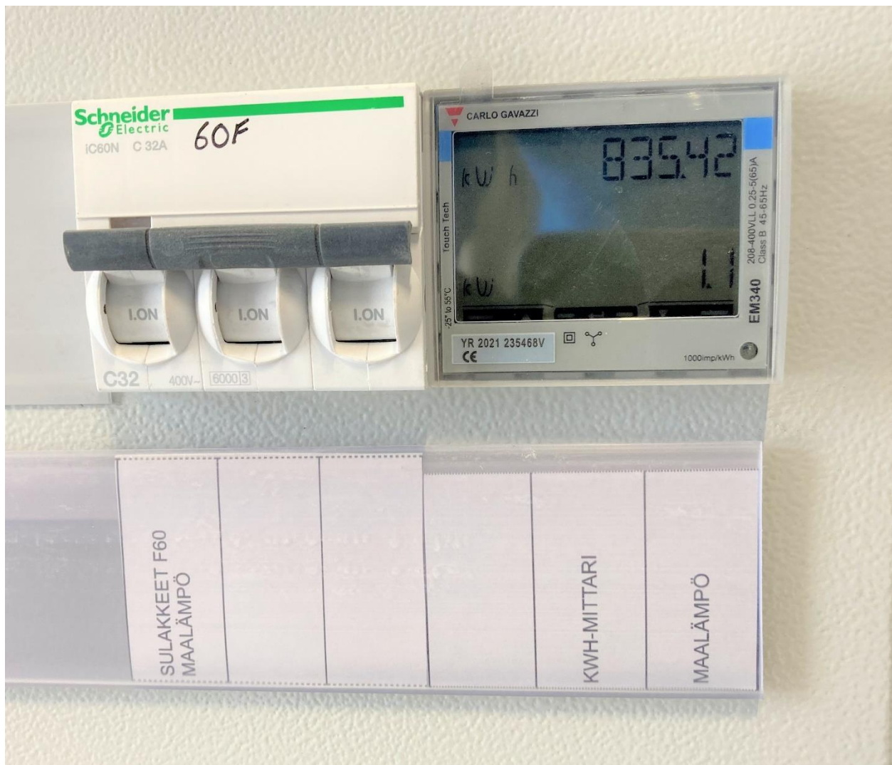
Kuva 6 Maalämpöpumpun kulutusmittari
