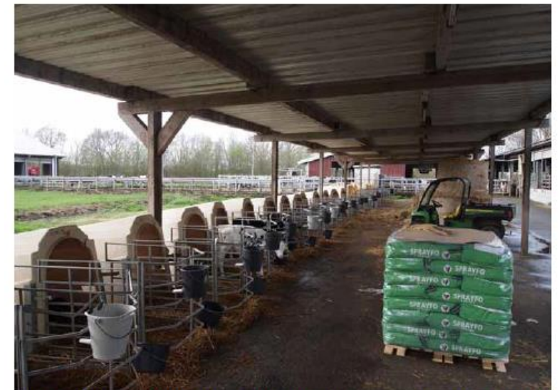
Kuva 26. Esimerkki tarkoituksenmukaisesta igluriviestöstä katoksen suojaissa. Rakenne on selkeän yksikertainen ja sen alla on helppo operoida mönkijällä tai pienkuormaajalla. Maanpinta on asvaltoitu. Kuva Tapani Kivinen.
