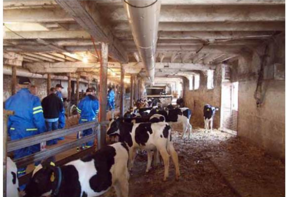
Kuva 13. Ylipainepuhallus asennettuna vanhoihin vasikkatiloihin. Ylipainepuhallukseen siirryttäessä vanhan rakennuksen tiiveys on purettava esimerkiksi poistamalla ikkunat ja asentamalla säädettävät kennolevyt tai verhot tilalle. Puhaltimen ja kanavan kustannukset ovat pienet. Ylipainepuhalluksella saavutetaan merkittävä parannus vasikoiden lähiympäristön ilmanlaatuun pienellä vaivalla. Kuva: Tapani Kivinen.
