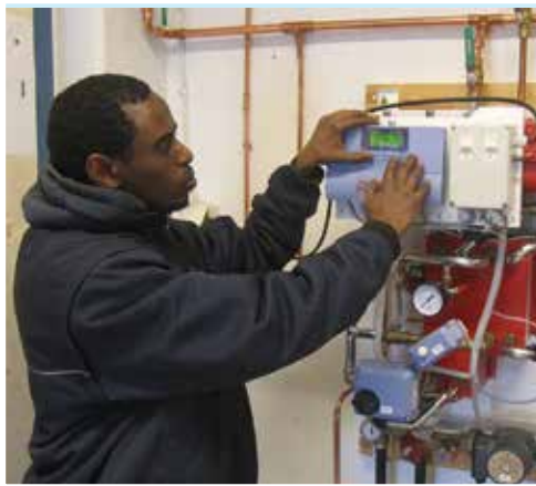
Ahmed Abdukadir säätämässä kaukolämpövaihdinta.
