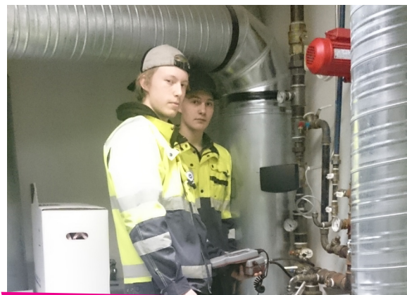
Aleksi Tiitinen ja Joonatan Elonen mittaamassa vesivirtaamia IV-konehuoneessa.
